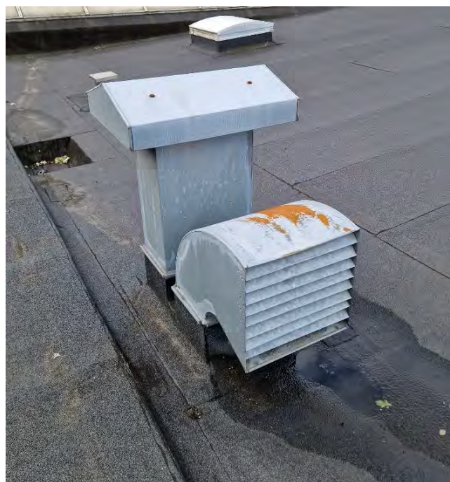
Figur 124: Indtag og afkast fra ventilationsanlæg til Hal 3.
