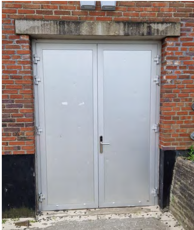
Figur 38: Nyere alu-dør til Hal 1 med niveaufri adgang og automatisk adgangskontrol.
