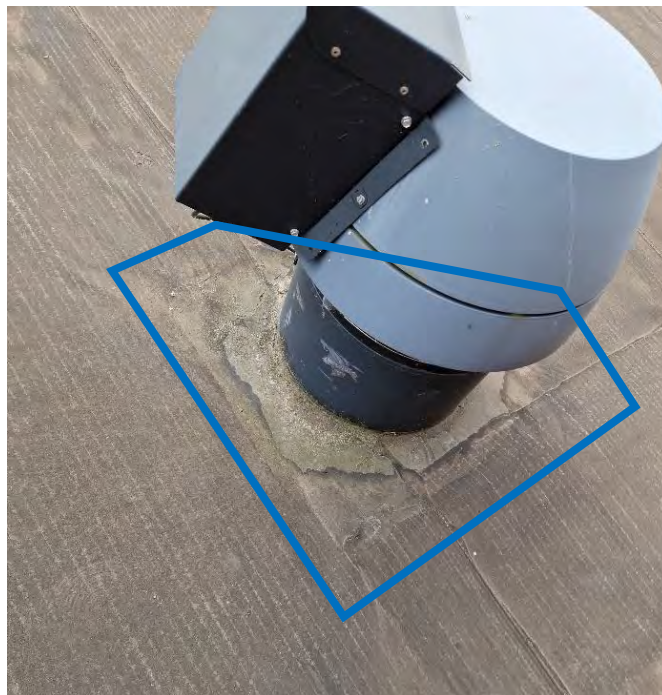
Figur 70: Lunke omkring taghætte på tag over aktivitetsrum.
