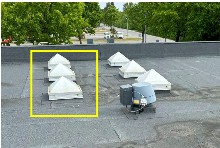
Figur 46: Ovenlys i omklædningsrum i Klub- og omklædningsbygning ligger tæt på tagfladen.
