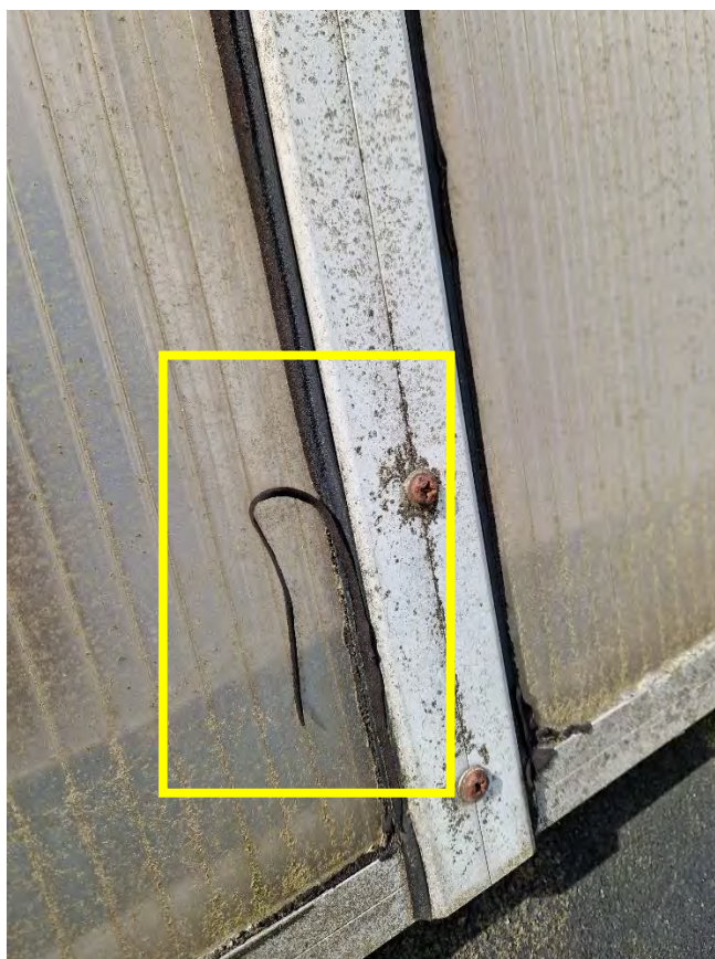
Figur 51: Fuge i rytterlys mellem Hal 2 og Hal 3 slipper.
