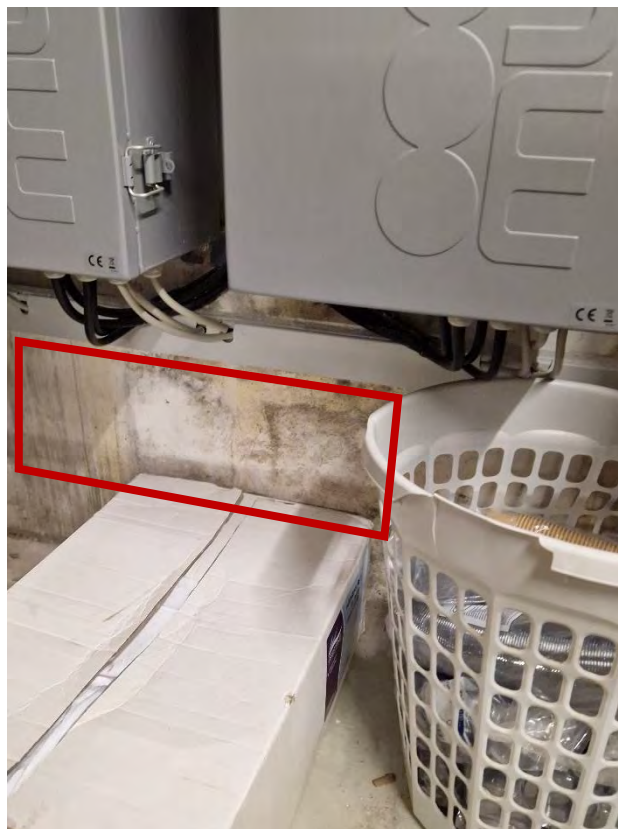
Figur 3: Fugtophobning i kældervægge og loft omkring gennemboringer
