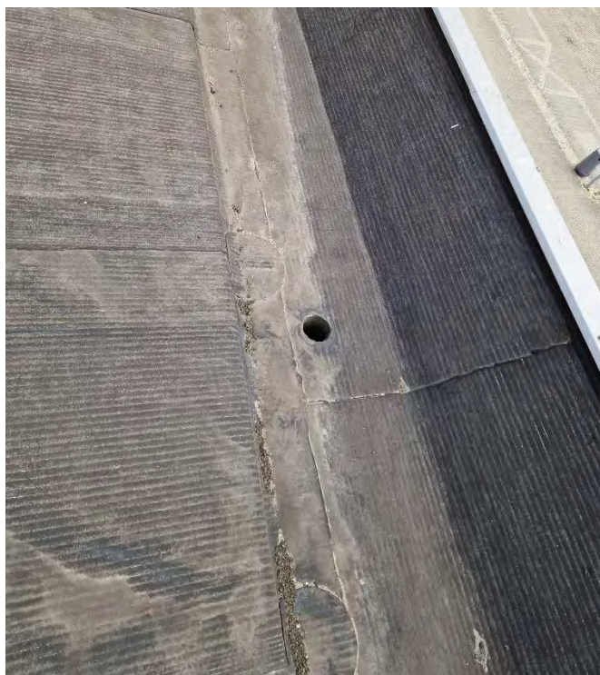
Figur 117: Afløb på taget af Hal 1.
