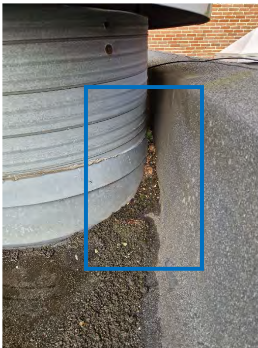
Figur 131: Afkast fra ventilation placeret tæt på opkant.
