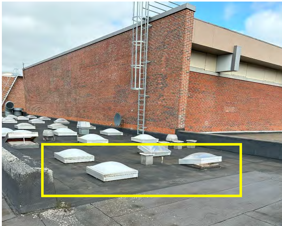
Figur 48: Ovenlys i omklædningsrum i cafeteria ligger tæt på tagfladen.
