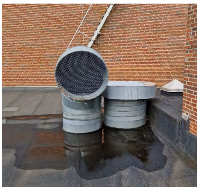
Figur 122: Indtag og afkast fra ventilationsanlæg til Hal 1, cafeteria og skydeklub.
