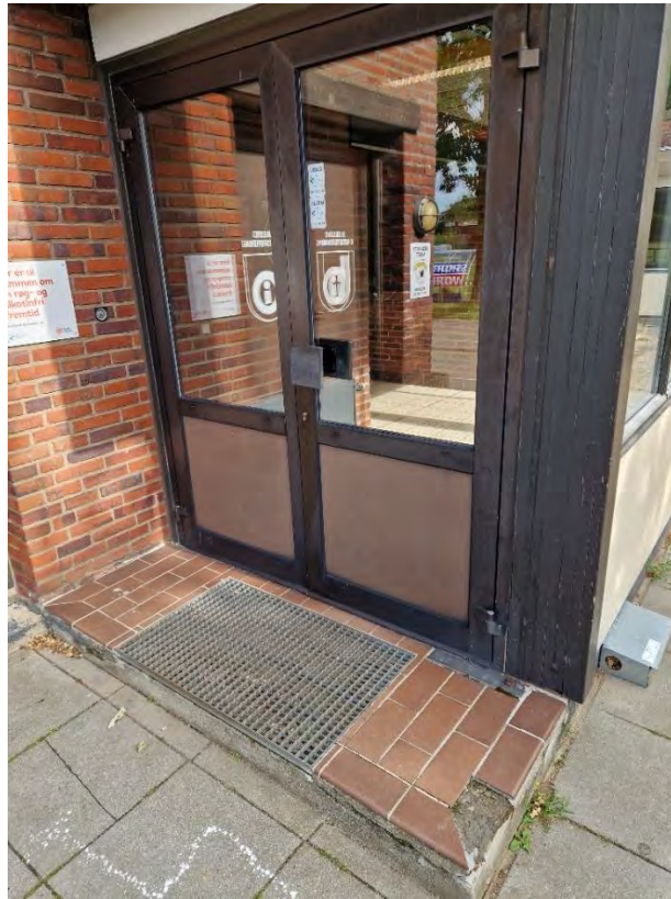
Figur 40: Gammel dør til omklædningsbygning.
