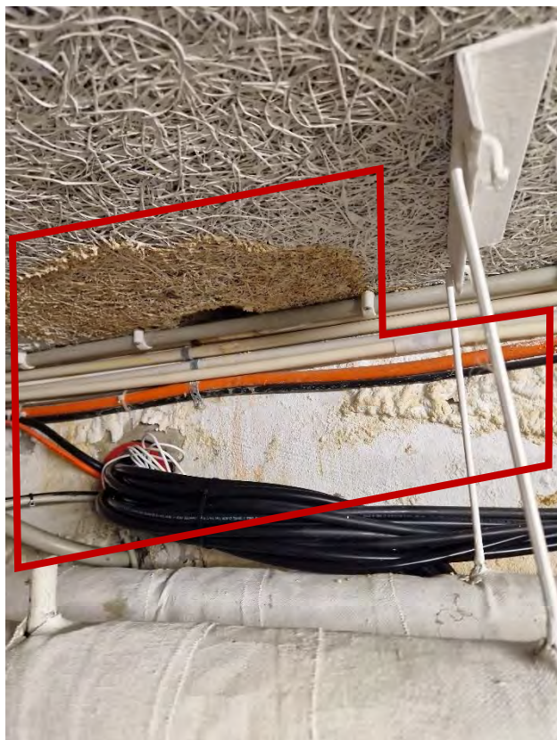
Figur 3: Fugtophobning i kældervægge og loft omkring gennemboringer
