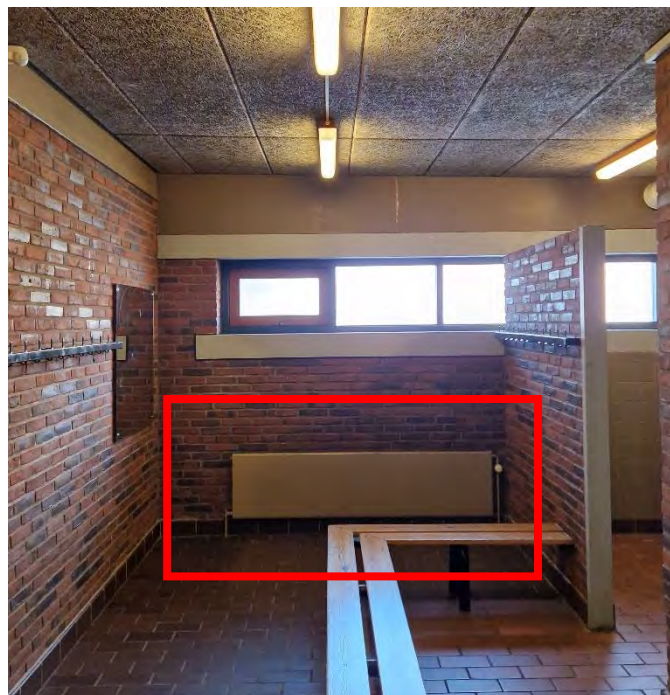
Figur 114: Radiator i Klub- og omklædningsbygning.
