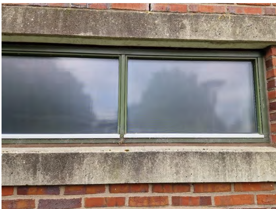
Figur 43: Vindue uden udhæng i omklædningsbygning.
