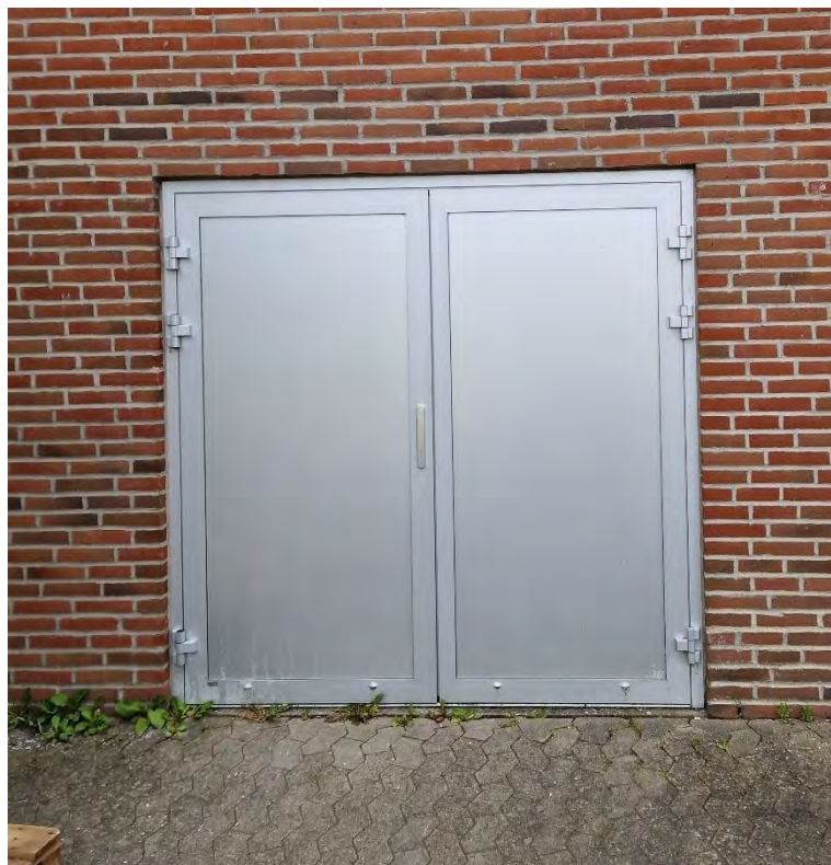
Figur 39: Nyere alu-dør til Hal 2 med niveaufri adgang.
