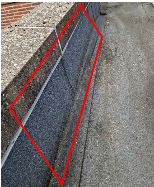
Figur 63: Høj opkant på Klub og omklædningsbygning.
