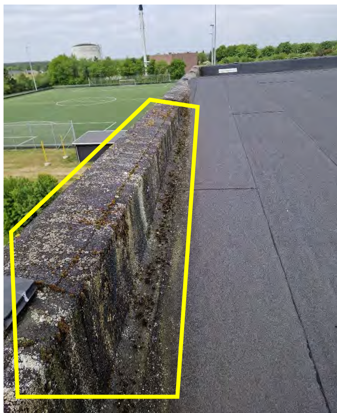
Figur 67: Biologisk vækst på murkrone på Hal 2.
