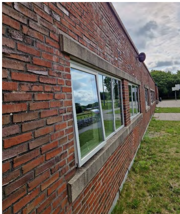
Figur 20: Beton sålbænke og overligger ved cafeteria.
