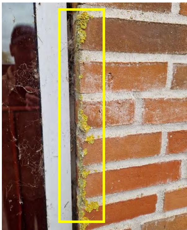
Figur 15: Vækst på hjørne af murværk ved springhal.
