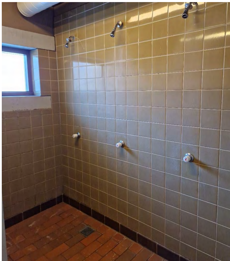
Figur 102: Gammelt klinkegulv i bade i Klub- og omklædningsbygningen.
